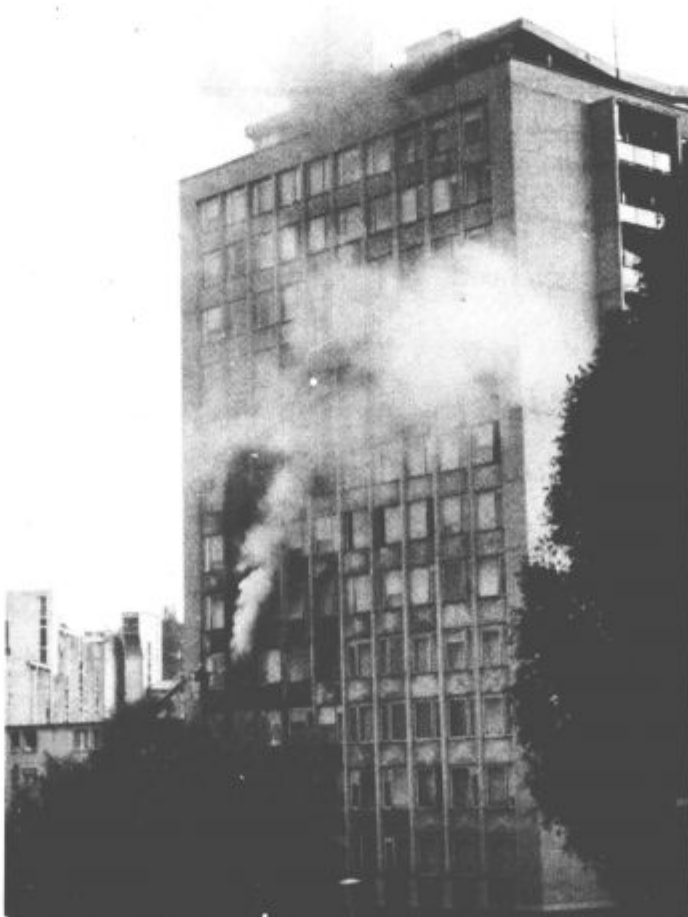
V požaru na Kersnikovi 1 v Velenju je nastala ogromna materialna škoda, zaradi zastrupitve z ogljikovim monoksidom pa so dva od stanovalcev morali z rešilci odpeljati v bolnišnico Topolšica, zdravniško pomoč pa je iskala še ena oseba. (foto: vos)
