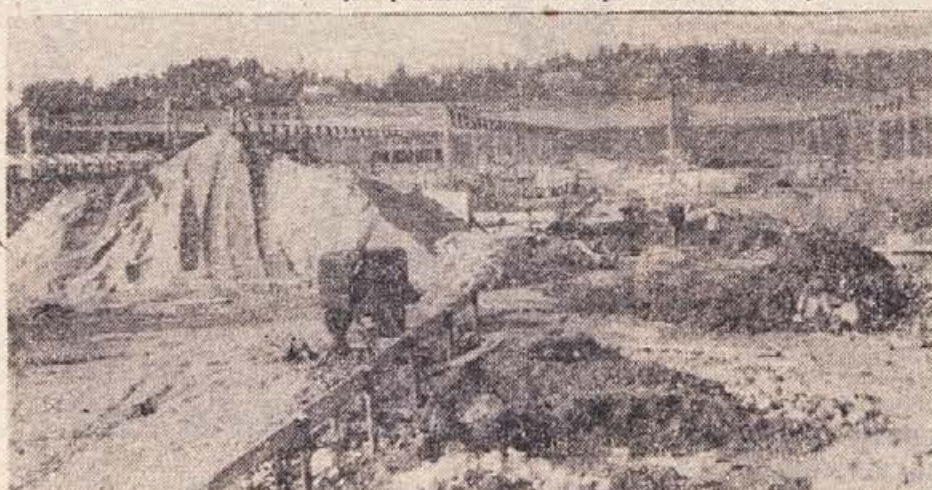
Novi objekti na gradbišču Kremenove steklarne v Bršlinu so že začeli dobivati pravo podobo. Po dolgotrajnih pripravljalnih delih so že postavili kovinsko ogrodje razsežne proizvodne dvorane
