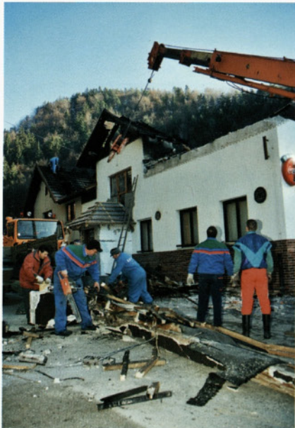
Vsaj vreme streže pri sanaciji.
