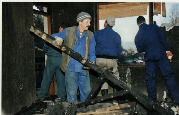
Večino čiščenja ostankov požara je bilo treba opraviti ročno. Foto: Dejan Tonkli
