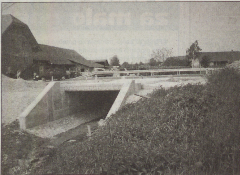
Rekonstrukcija ceste R1-230/1308 Vučja vas - Križevci; izgradnja dveh propustov
