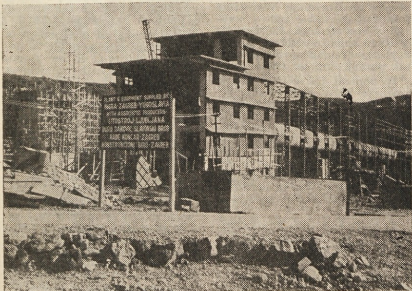
Gradbišče cementarne v Cherrapunji v Indiji — gradnja dimne komore
