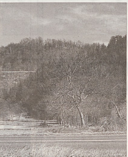
"Kolosalni nasip pri Bitnji" je danes močno zaraščen, zato lahko le slutimo veličino gradbenega podviga. Velik in dolg prehod na vznožju nasipa, izdelan in tlakovan iz klesanega kamna, omogoča pot vozovom in potoku. Tu lahko izmerimo širino nasipa, kar 260 korakov meri. Velikašno, da je kaj. (Foto V. Čeligoj)
