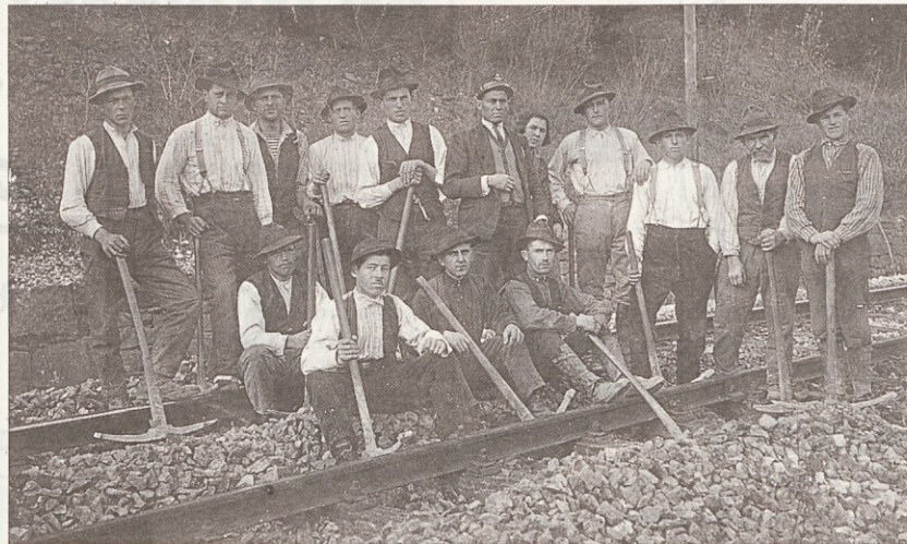
Delavci so pri vzdrževanju proge opravljali verjetno najbolj težko delo na železnici. S težkimi "pikoni", krampi-podbijači so nabijali kamenje pod tračnice in tako utrjevali progo. Uprava železnic je za občasna dela novačila krepke fante in može kar med domačini. Ti so delo radi sprejeli, saj za zaslužek ni bilo veliko priložnosti. Na sliki skupina priložnostnih delavcev iz Mereč in Podstenj pri vzdrževanju proge, verjetno v bližini Mereč okrog leta 1926.
