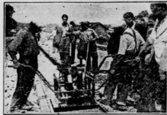
»Vibrator« za nabijanje robnih trakov
