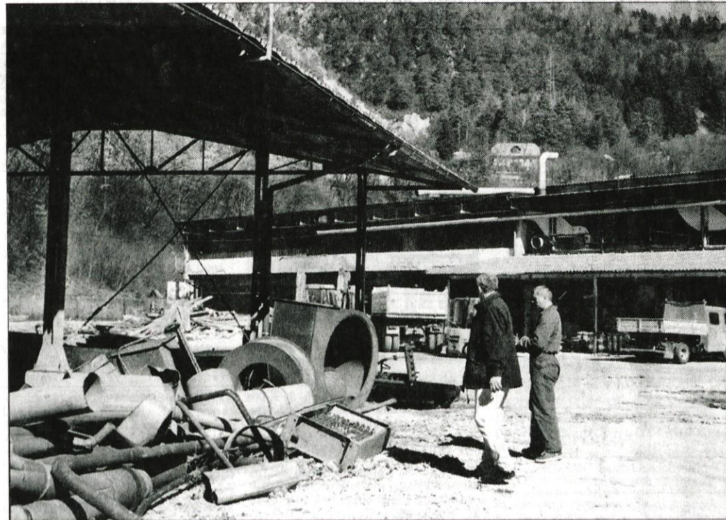
V nekdanjem ZLIT-u so porušili dotrajane stavbe in odstranili odpad z dvorišča.
