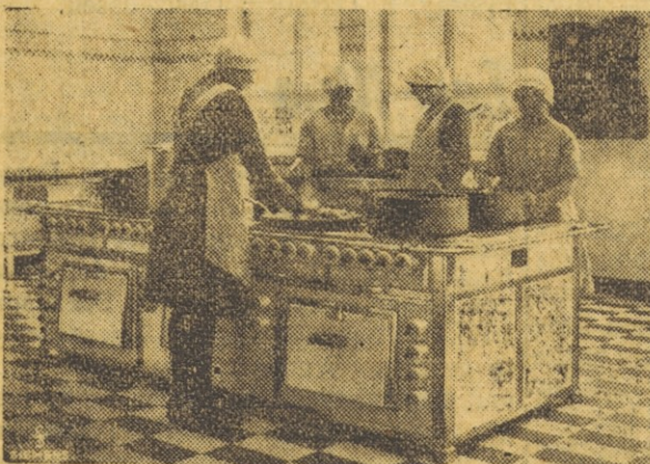
Elektrischer Großküchenherd aus dem Jahre 1927 mit untergebaute Bratrohr.
