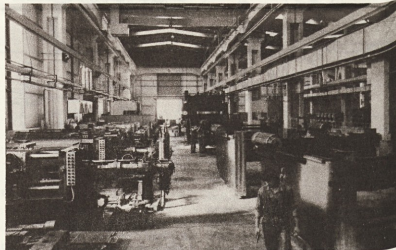
Montaža hidravličnih strojev na 5. polju v novi montažni hali tozda PPO (Foto: E. L.)
