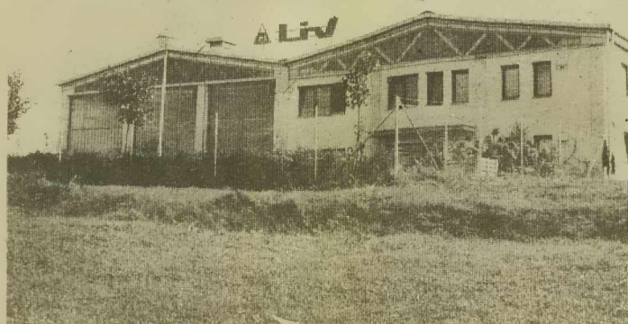
Obrat „LIV“ Postojna, TOZD Oprema in orodja Rogoševci
