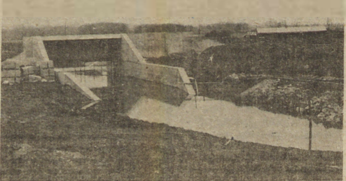
Zapornica zadrževalnika v Bolehnečcih. Melioracije naj bi pripomogle k še večjim hektarskim nadosom in pridobivanju še več krme za živino, ki je v teh krajih precej.
