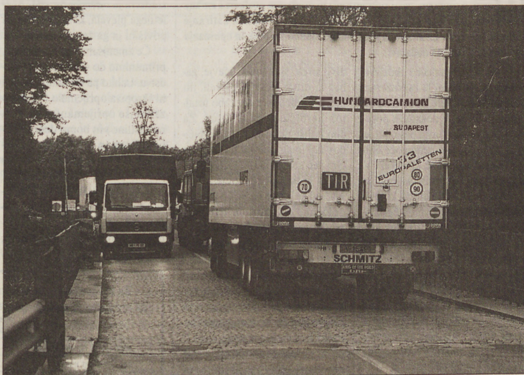
Domačine, ki živijo v krajih ob Muri, zanima, kako bodo obnavljali mostove in ceste med Petanjci in Radenci. Na sedanjem cestišču namreč ni prostora za pešce in kolesarje. FOTO: NATAŠA JUHNOV
