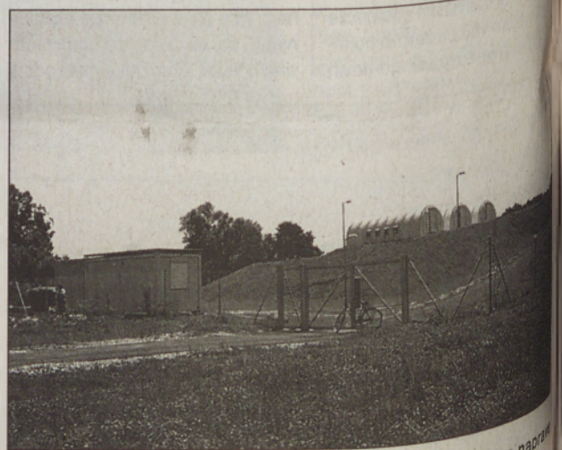
Dograditev kanalizacijskega omrežja in zgraditev čistilne naprave (na posnetku) je bila največja naložba v minulem obdobju.
