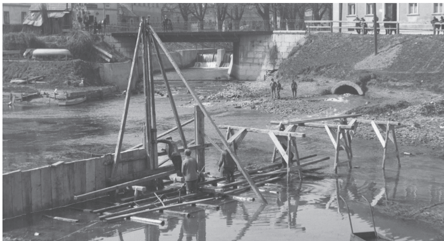
Gradnja zapornice (Vir: SI_ZAL_LJU342, fototeka, A3-241 007)
