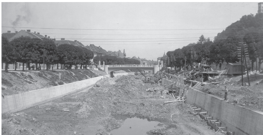
Regulacija struge na mestu zapornice leta 1931 (Vir: SI_ZAL_LJU342, fototeka, A02-152)
