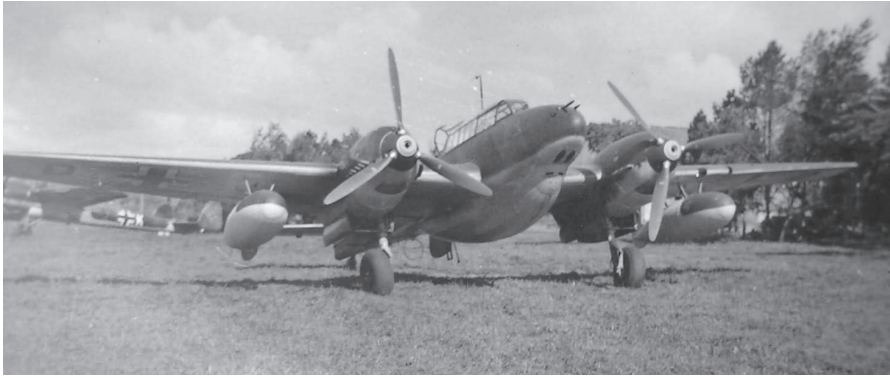
Zgodnji Bf 110D s fiksnim dodatnim rezervoarjem pod trupom in dvema 900-litrskima rezervoarjema pod krili
