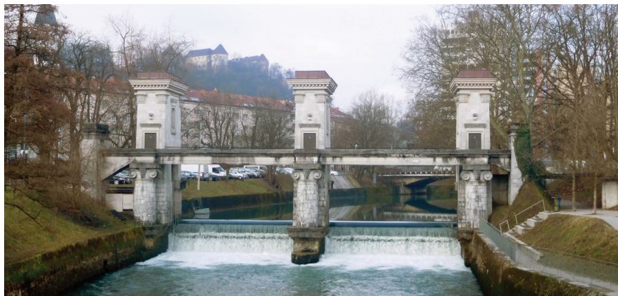
Pogled na zapornico v smeri proti centru mesta (Foto: Maja Oven)
