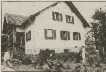
Simončičev iz Iljaševca se so odločili za temeljito obnovo; na staro arhitekturo spominja le nekaj detaljev, npr. talni zid, vhod...
