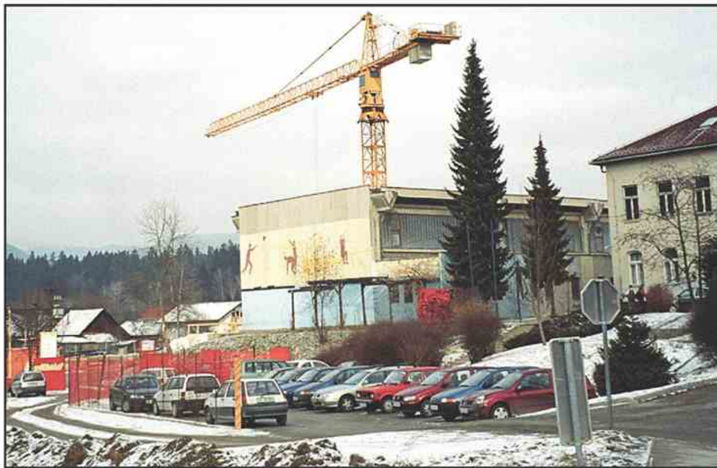
Staro se umika novemu. V petek so začeli rušiti telovadnico ob šoli.
