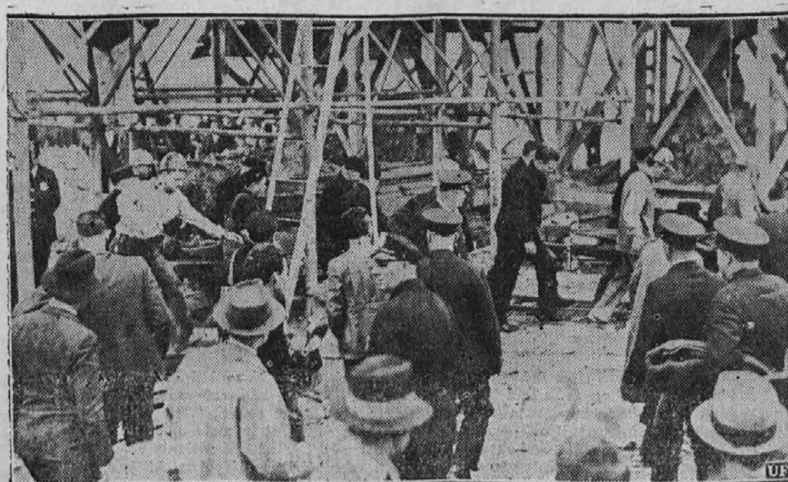
Pet slovenskih življenj je zahtevala nesreča, ko je na nekem kraju v Detroitu nedavno prišlo do eksplozije v podzemnem kanalu. Priisk je bil tako silen, da je vrgel zemljo in podpirajoče tramovje v kanalu 150 čevljev visoko v zrak.
