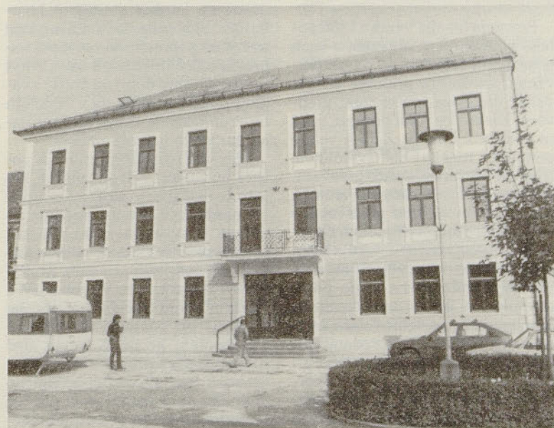
V dogovorjenem roku obnovljena stavba interne banke že služi namenu.
