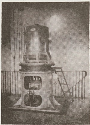
Vodovod Zagreb: črpalna postaja v Mali Mlaki
