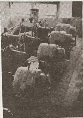
Črpalna postaja vodovoda Novi Sad
