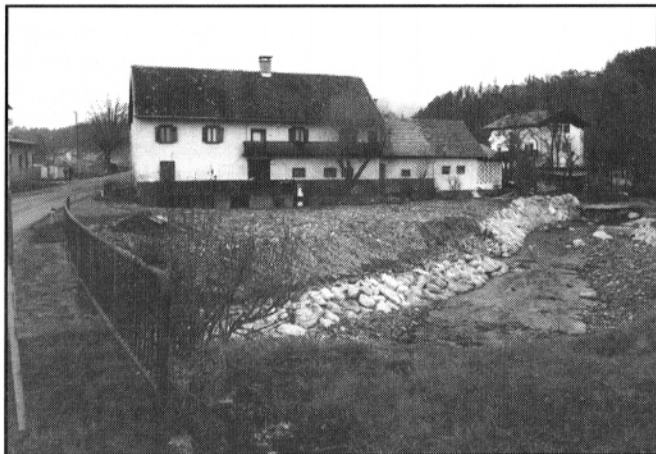
Klavrna podoba "saniranega" vodotoka Ljubija po zadnji poplavi (foto: B. Kanjir)
