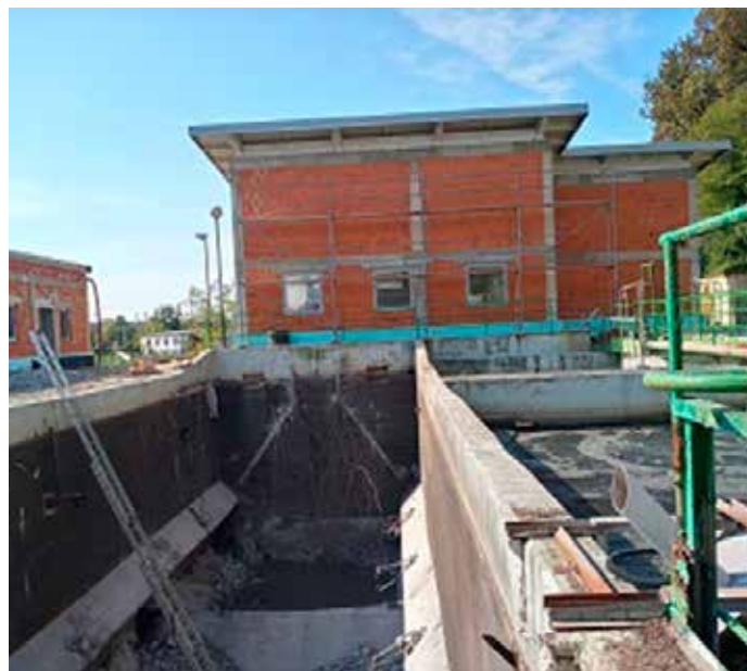
Izpraznjen bazen usedalnika pred rekonstrukcijo Foto: Zavod za informiranje Ormož - Radio Prlek
