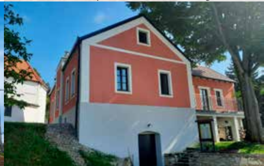
Energetska sanacija-Košarkina Kog
