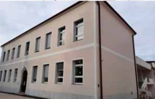
Energetska sanacija-OŠ Podgorci
