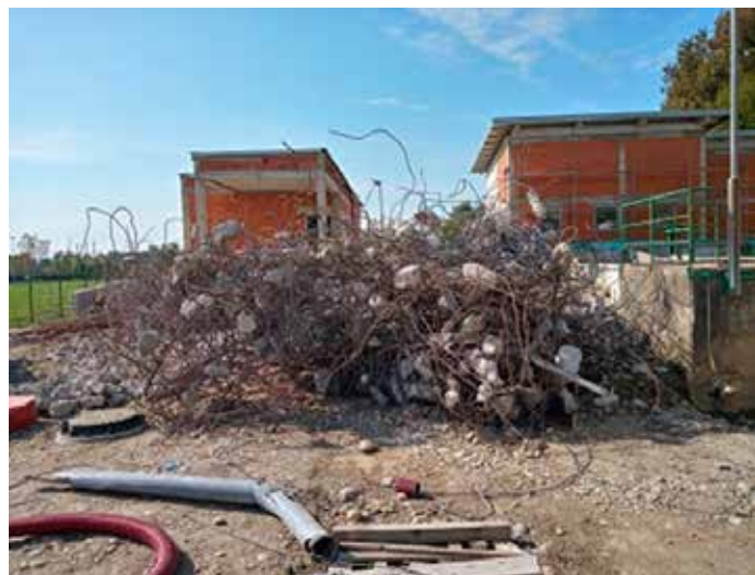
Odstranjena armatura in stari beton usedalnega bazena
