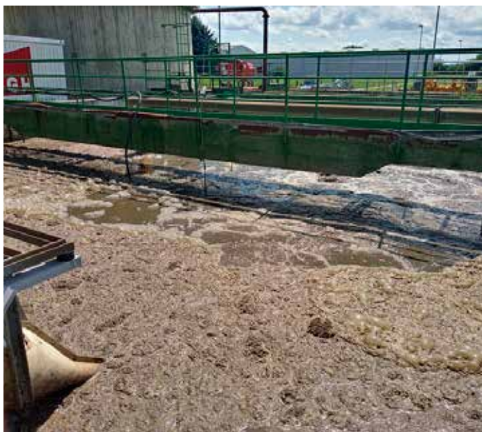
Čistilni bazen, kjer trenutno poteka čiščenje odpadnih voda Foto: Zavod za informiranje Ormož - Radio Prlek
