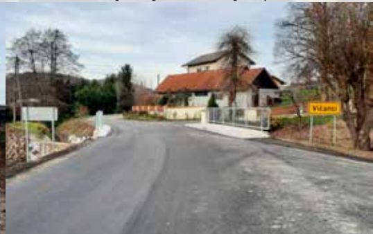
Obnova mostu v Vičancih
