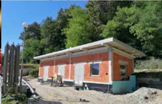
Rekonstrukcija in nadgradnja čistilne naprave Ormož
