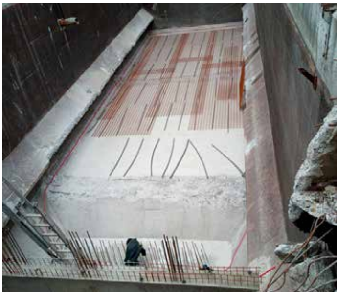
Usedalni bazen je bilo potrebno tehnološko predelati. Vidne so vgrajene nove armature in beton.
