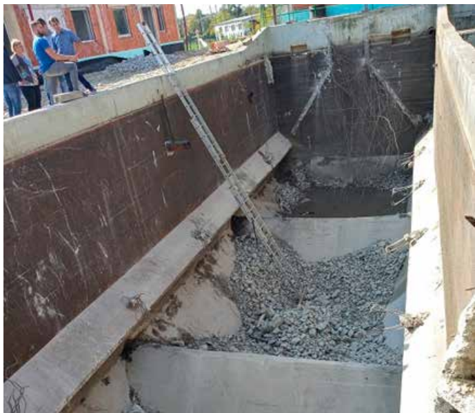
Odstranitev dotrajanih betonov in armature v samem usedalnem bazenu
