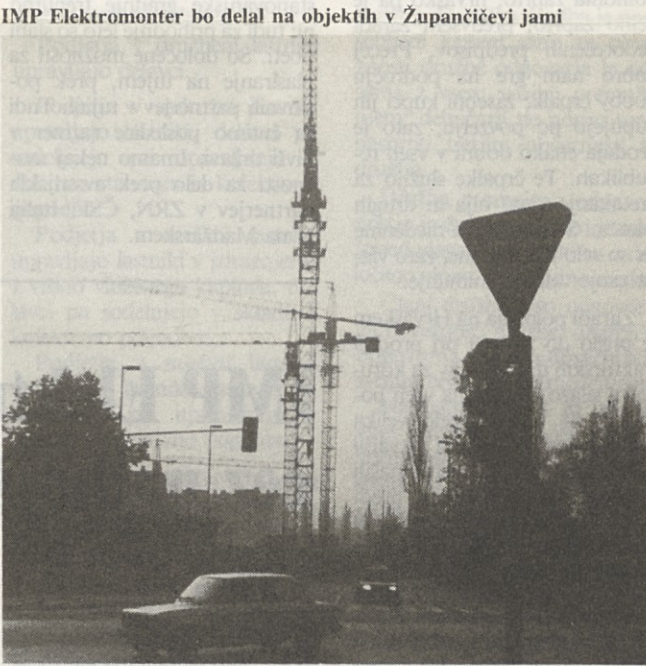
IMP Elektromonter bo delal na objektih v Župančičevi jami
