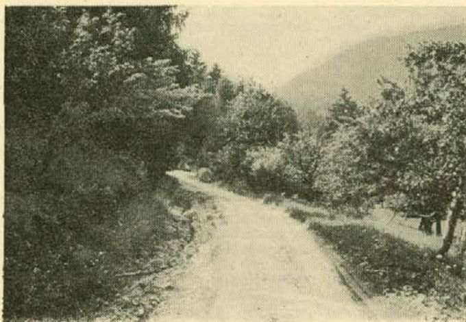
Nepravilno grajena in vzdrževana cesta, foto D. Dretnik
