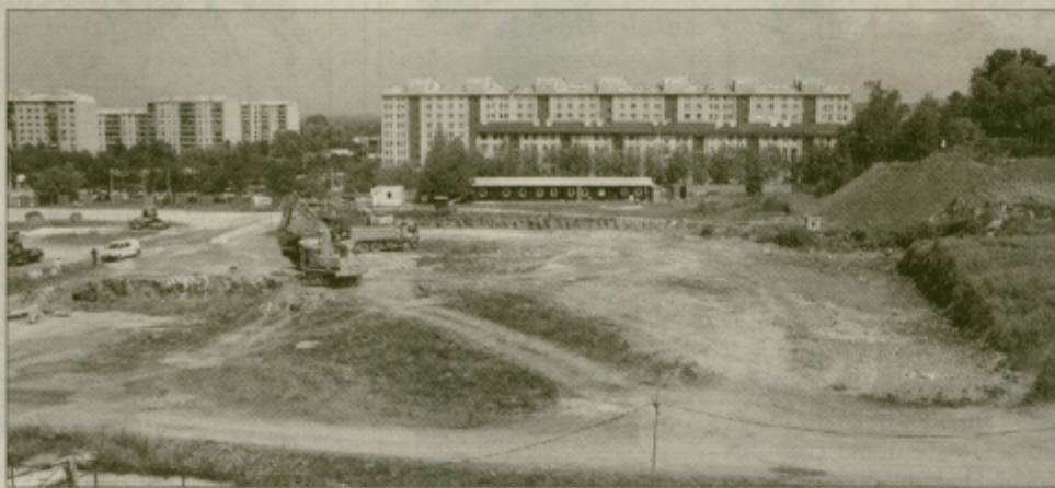
Gradbišče Mercatorjevega celjskega Koloseja.
