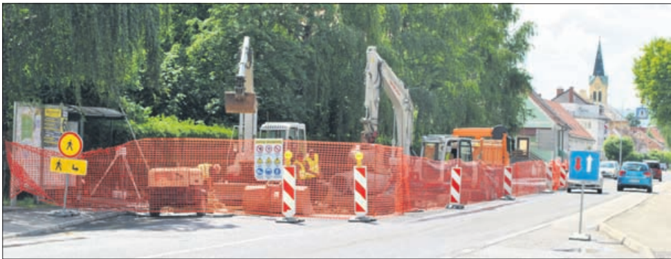
Stroji so pripravljeni, obnova žalskega mestnega jedra se začinja.
