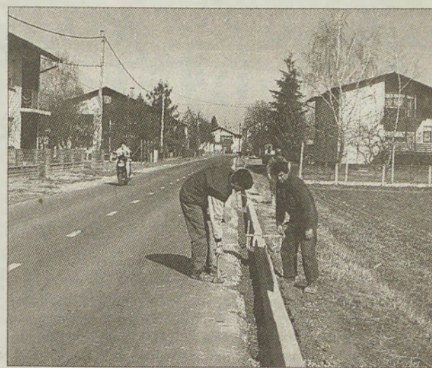
UREJANJE ROBNIKOV IN PLOČNIKOV V VEŠČICI - Od lanske jeseni so delavci podjetja za nizke gradnje Nigra iz Murske Sobote angažirani pri gradnji kanalizacije, polaganju robnikov, urejanju pločnikov, asfaltiranju in širitvi nekaterih cestnih križišč. Načrtujejo, da bodo z deli končali čez približno mesec dni. Besedilo in fotografiji: M. JERŠE
