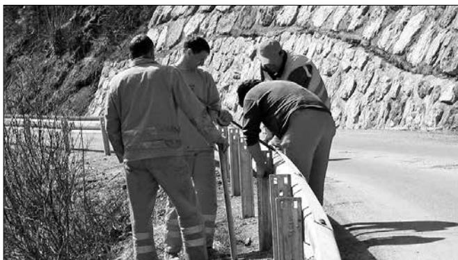
Postavljanje odbojne ograje na kritičnem delu ceste (Foto: Marija Lebar)
