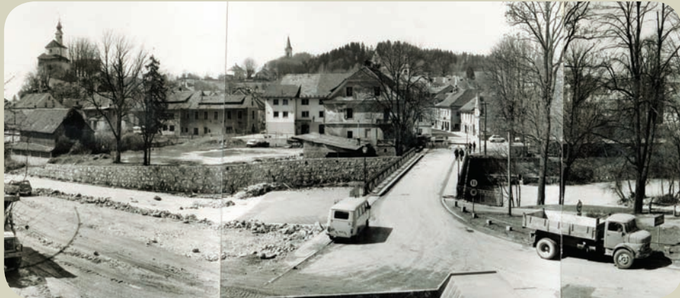
1980~2010 | Pogled na Kamnik s pobočja Starega gradu v času gradnje obvoznice.
