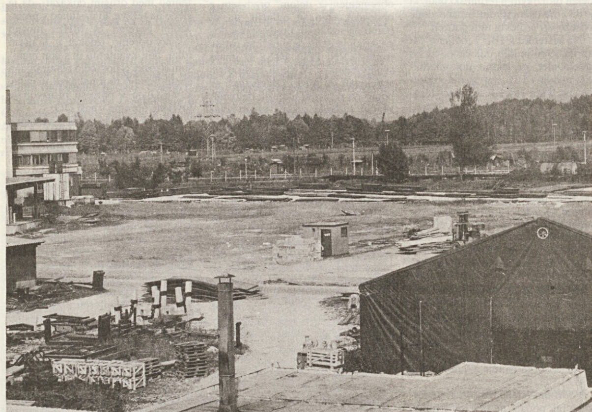
Priprava terena za pričetek gradnje težke obdelave (Foto: t.š.)
