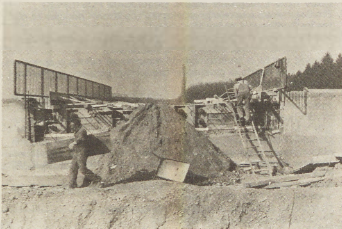
Gradnja mostu čez Ledavo med Gančani in Bogojno.
