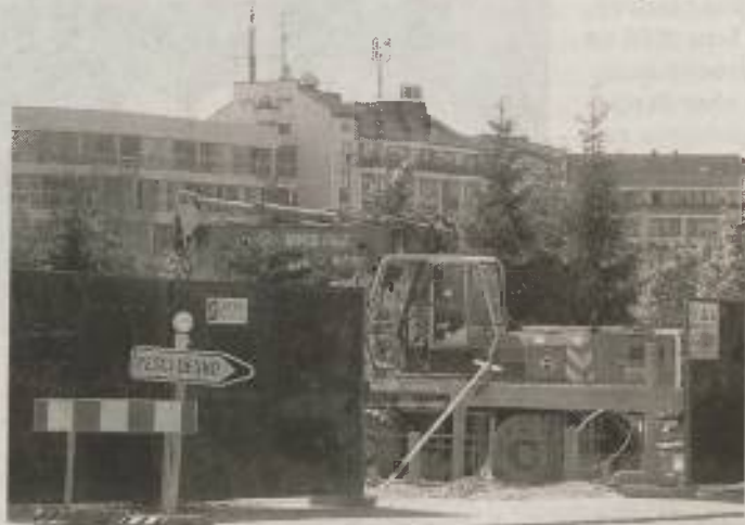
Gradbišče pred Termami 3000, ki se je načrtno vrnilo pred hotel, zgrajena stavba pa bo zakrivala pogled na novi hotelski kompleks, ni v veselje vodstvu zdravilišča. Le zakaj niso odkupili sosednjega zemljišča?
