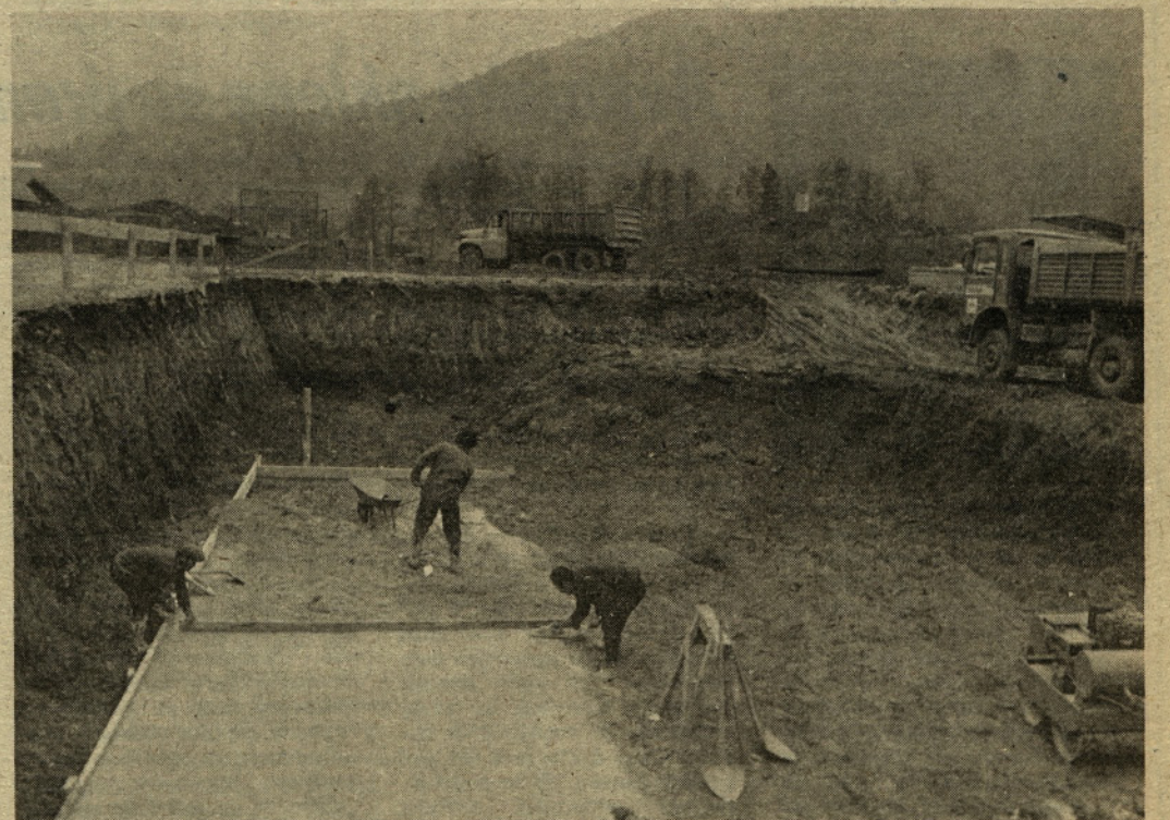
Gradnja temeljev novega preskrbovalnega centra
