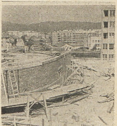
Gradnja novega šišenskega centra hitro napreduje. Na sliki vidimo betoniranje zadnje betonske plošče pri novi kino dvorani
