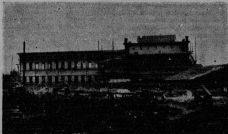
Glavni transformator na Črnučah.
