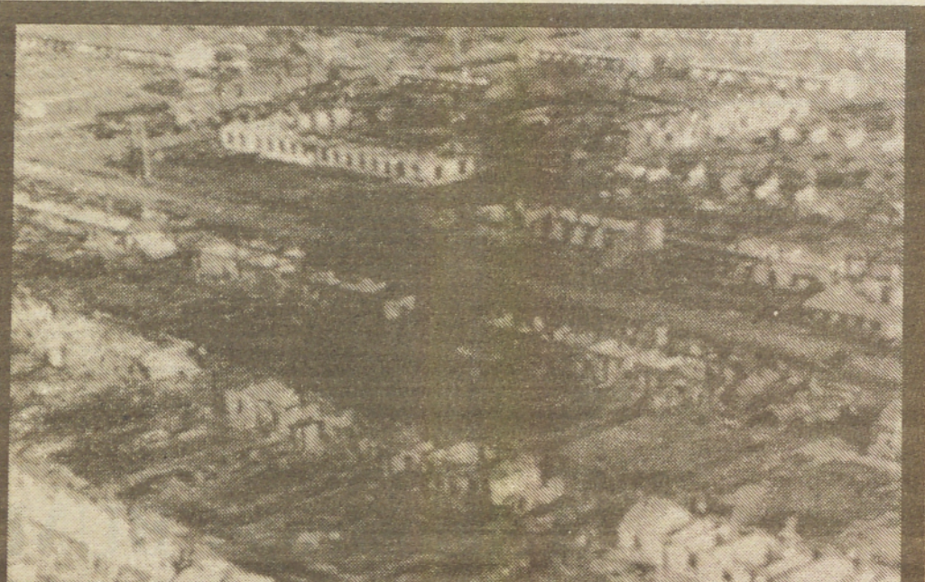
Že skoraj mesec dni pustoši gozdove na severovzhodu Kitajske. Doslej je uničil tudi nekaj mest. Doslej je požar terjal 191 mrtvih in 221 hudo ranjenih. Na sliki eno izmed mest v okrožju Mohe po požaru.
