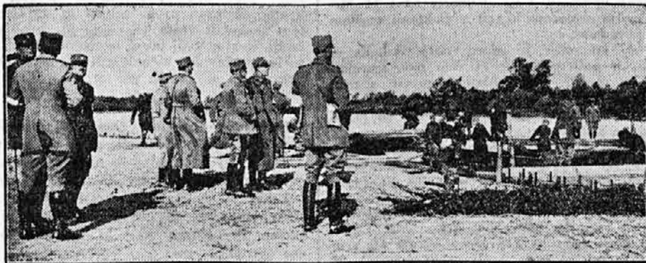
Generaliteta opazuje gradnjo pontonskega mosta
