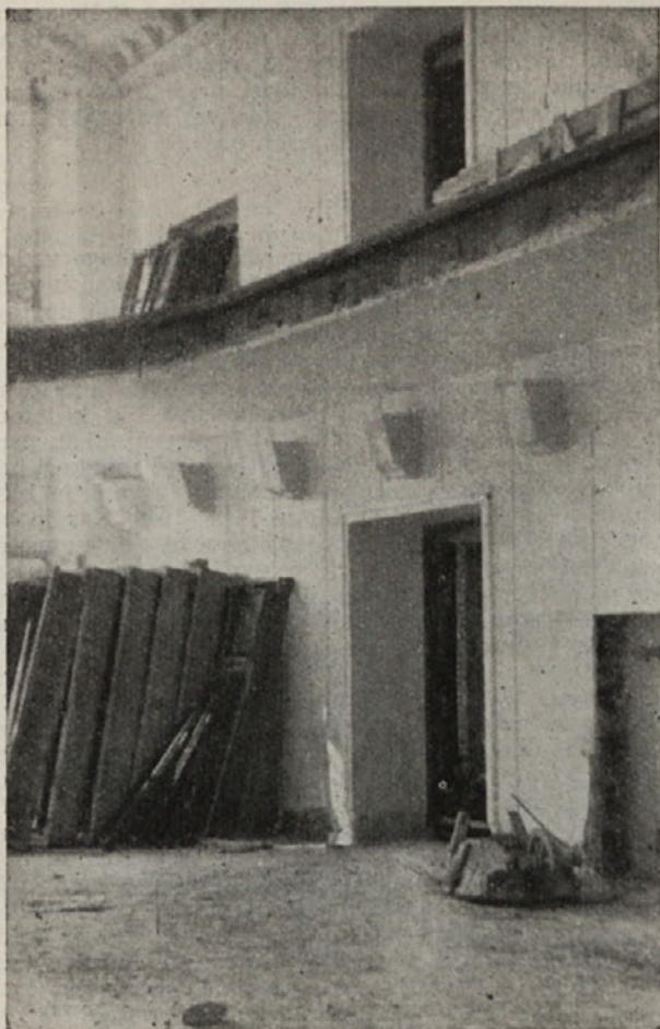
Pogled v foyer med gradnjo l. 1952
