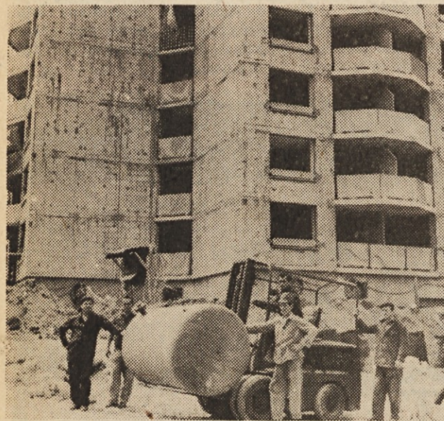
Viličar „Slonček“ pomaga monterjem vodovodnih instalacij
