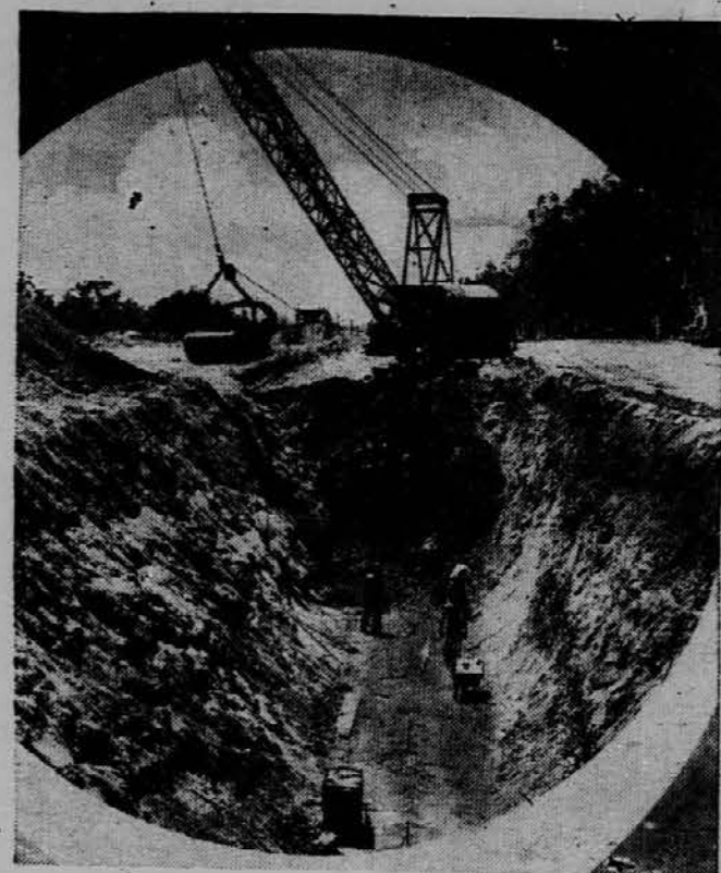
Tisoči delavcev so zaposleni pri gradnji 242 milj dolgega vodovoda. Vodo bodo dobivali prebivalci Los Angelesa in drugih mest of pacifični obali iz Colorado rekee.
