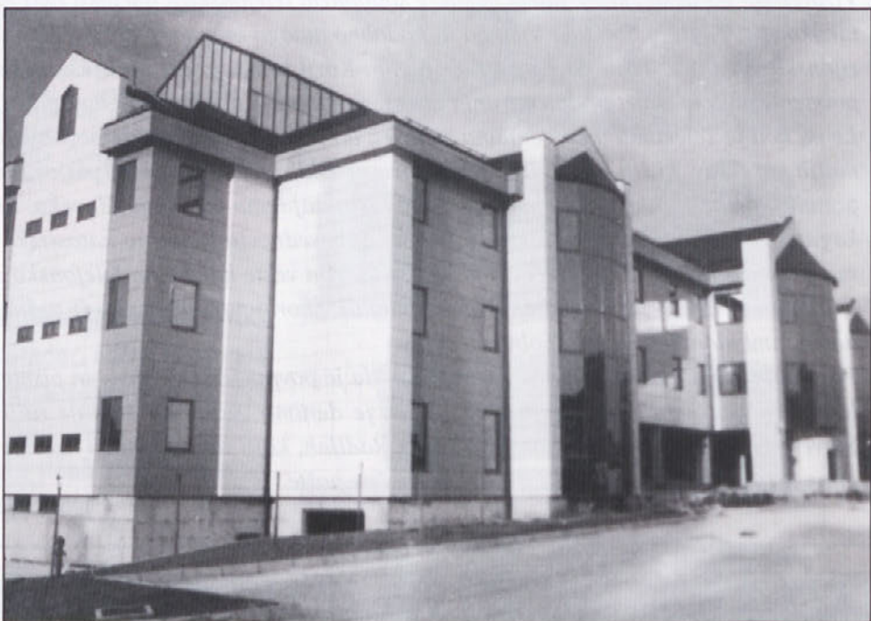
Stavba slovenjgraške Katice pred zaključkom gradbenih del
