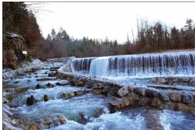
V dogovoru z Ribiškima družinama Ljubno in Mozirje ter Zavodom za ribištvo Slovenije je izvajalec uredil tudi stezo za prehod rib in ostalih vodnih organizmov. (Foto: Primož Vajdl)
