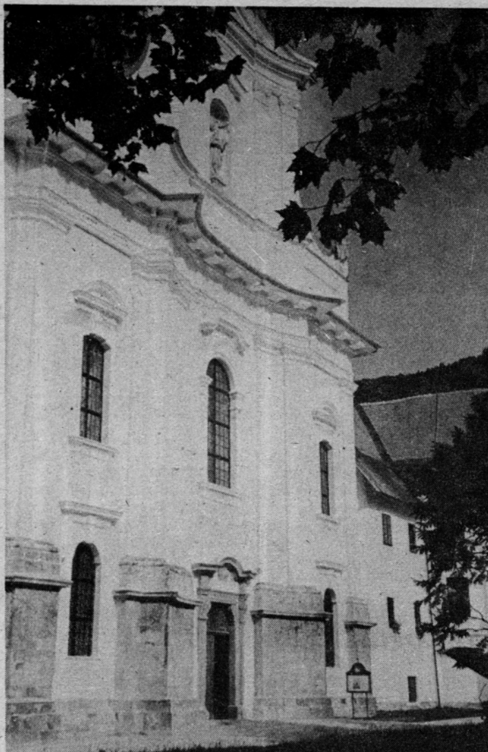
Pročelje prenovljene katedrale v Gornjem gradu. Kamniti portal še čaka na prenovo.
