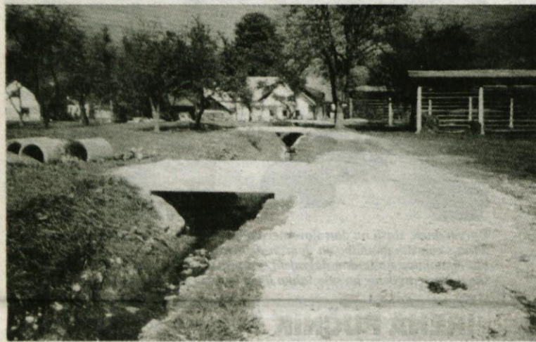
Del sanirane struge hudournika Osranc.
