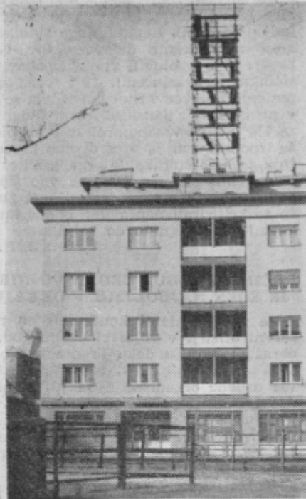
Na stanovanjski blok v Ključavničarski ulici, tako imenovani celjski neboščnik, so te dni postavili 24 m visoko anteno relejne postaje Celje
