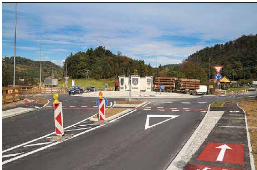
Z izgradnjo krožišča Soteska je konec nevarnega vključevanja na cesto iz smeri Gorenja.
