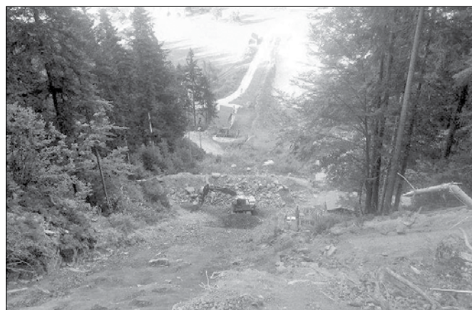
Zemeljska dela na ureditvi skakalnice (Fotodokumentacija Občine Ljubno)
