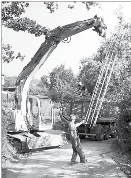
Gradbena dela na prvem, najboljsežnejšem zdrsu ceste so potekala zaradi zahtevnega vrtnja in betoniranja pilotov zelo počasi.
