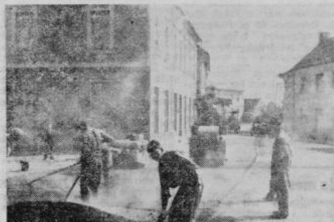
Med polaganjem zadnje plasti asfalta na osrednjih plujskih ulicah
