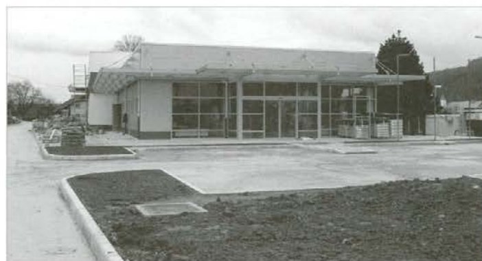
Nova zadržna trgovina v Mislinji med gradnjo
