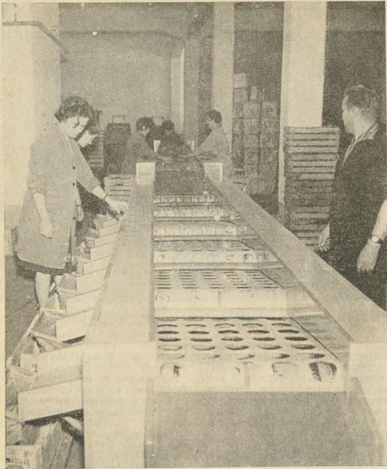
PE »Sadje zelenjava«: Kalibrator za sortiranje sadja
