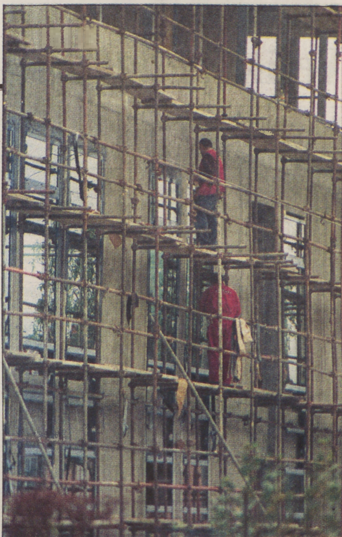
Tudi v Murski Soboti je podjetje Reflex že zelo znano; kmalu bodo odprli obnovljene in razširjene prostore obrata v Kopališki ulici, ki naj bi postal »super servis«. Posnetek je nastal na gradbišču pokrajinske knjižnice, kjer delavci montirajo fasado iz Reflexovega stekla.
